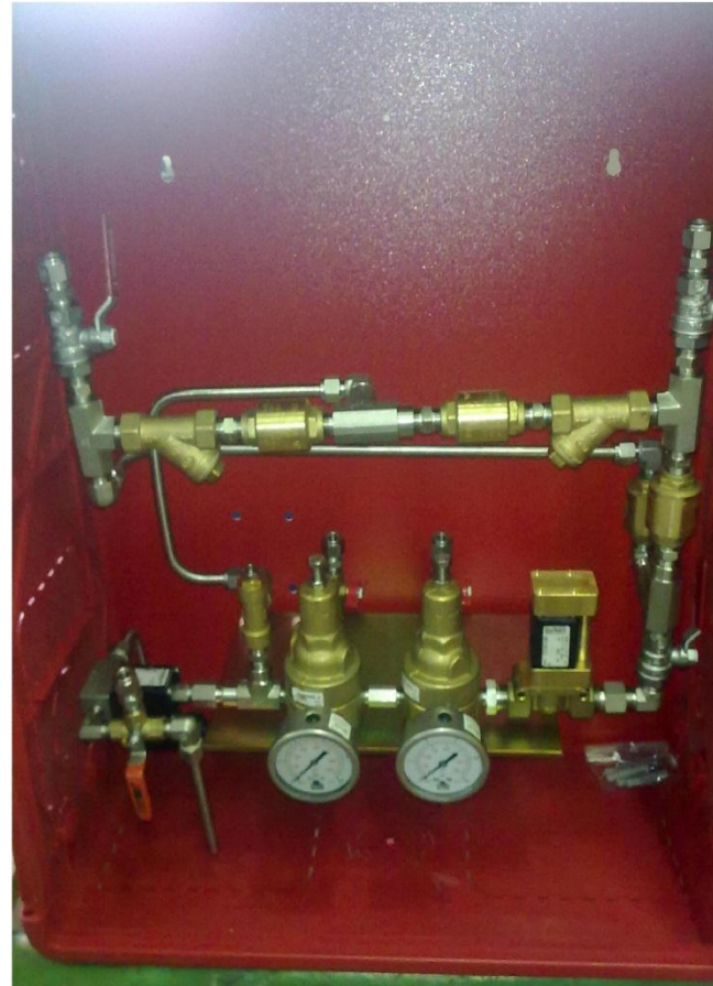
Sistema di pilotaggio della Idrovalvola
