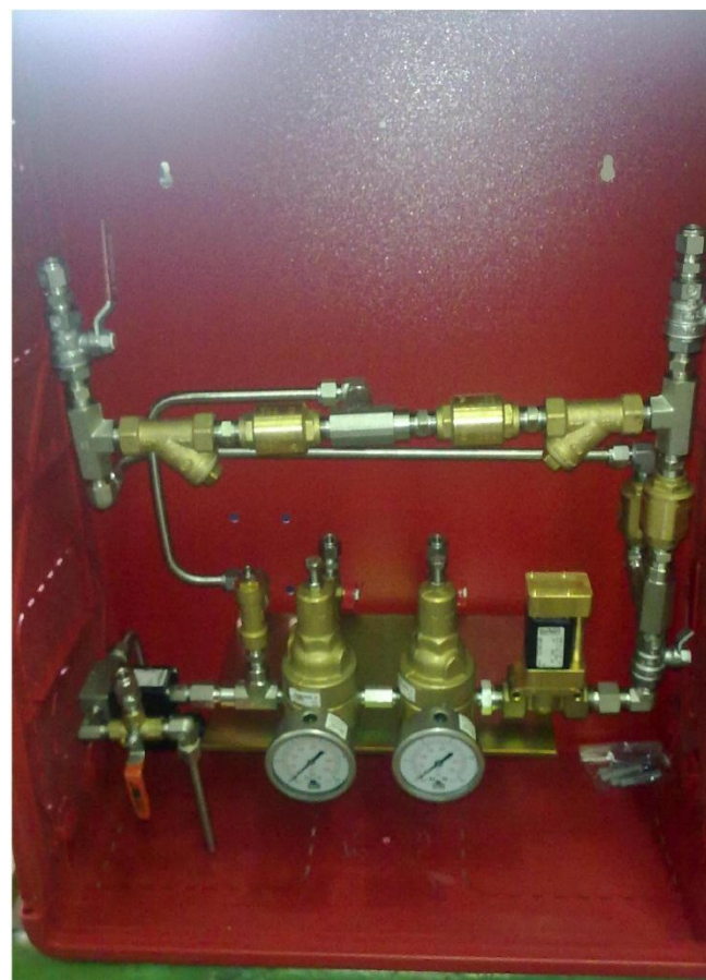
Sistema di pilotaggio della Idrovalvola
